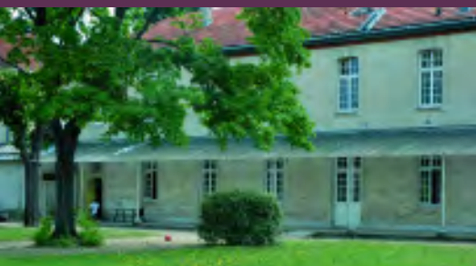
Pavillon Alizé / Quartier bleu Hospitalisation, Patients au long cours, secteurs G10-G11-G12, Asile, division des hommes, 2ème quartier Architecte : Paul-Eugène Lequeux 1864/1868
