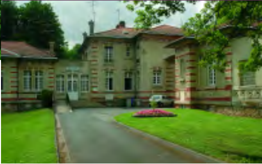
Pavillon Provence / Quartier vert Hospitalisation, Psychiatrie adulte, secteur G16 Maison de santé, pavillon dit de traitement continu Architecte : Raphaël Loiseau, 1907
