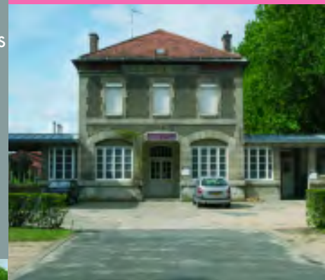
Pavillon Falret Quartier bordeaux Médecine du travail, Architecte : Henri Maréchal 1876/1880
