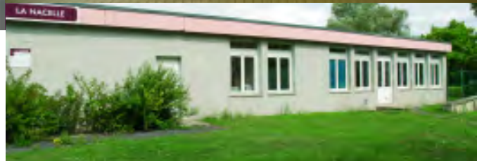
Pavillon La Nacelle / Quartier bordeaux Hospitalisation infanto-juvénile, secteur I03 Construit en 1968 Architectes : G.Masse / J.Mathiot
