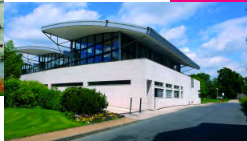
Self / Quartier orange Cuisine-unité de production des repas 2000 Architectes : Dellaitre, Crosnier, Besson-Sogno
