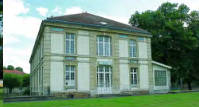
Pavillon Béarn / Quartier vert « Plan blanc » Maison de santé, division des dames, Désaffecté depuis 2002 Architecte : Henri Maréchal, 1885/1889
