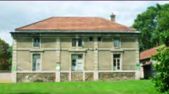
Pavillon Bretagne / Quartier vert Associations culturelles du personnel (théâtre, photo) Maison de santé : pavillon cellulaire Désaffecté depuis 1980 Architecte 3 : Paul-Eugène Lequeux et Henri Maréchal, (en 1887/1889, Bretagne existait)
