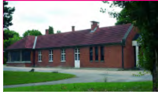
Amphithéâtre / Quartier bleu Espace loué Ancienne morgue, 1950 Architecte : non communiqué
