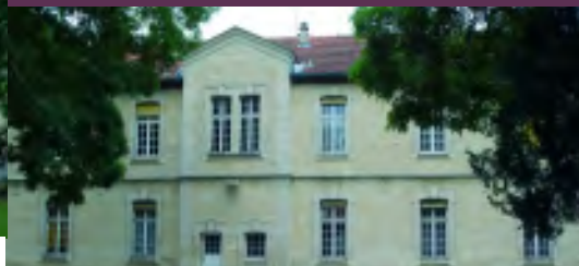
Pavillon Poussin / Quartier bleu Asile, division des femmes, 4ème quartier Dénomination originelle : Pavillon Pussin Désaffecté depuis 2003 Architecte : Paul-Eugène Lequeux
