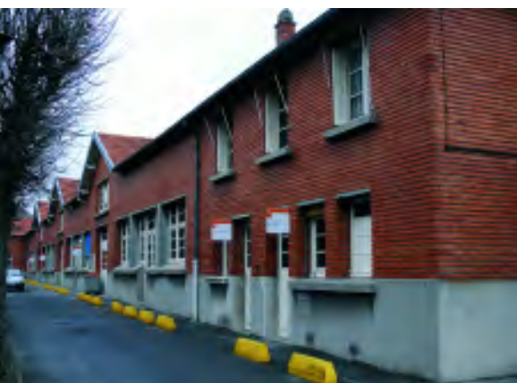
Les ateliers / Quartier orange 1950 Architecte : Gaudre
