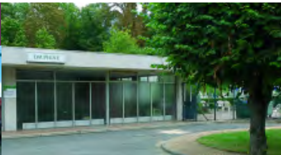
Pavillon Dauphiné / Quartier vert Hospitalisation, Psychiatrie adulte, secteur G18 Construit en 1967 sur l'emplacement d'un ancien pavillon cellulaire. Architecte : W. Gordeef
