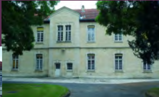
Pavillon Chaslin / Quartier bleu Formation incendie Asile, division des femmes, 3ème quartier Désaffecté depuis 2000 Architecte : Paul-Eugène Lequeux 1864/1868
