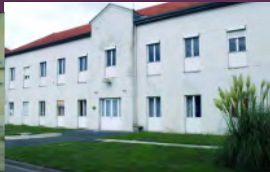
Pavillon Moreau / Quartier bleu Psychiatrie infanto-juvénile, secteur I03 Asile, division des hommes, 4ème quartier Désaffecté depuis 1999 Architecte : Paul-Eugène Lequeux 1864/1868
